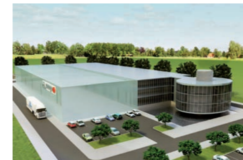
Centro de Serviços em Zweibrücken, Alemanha
